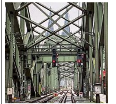
Die Bahn plant Bauarbeiten am Hauptbahnhof. Foto: Berger
