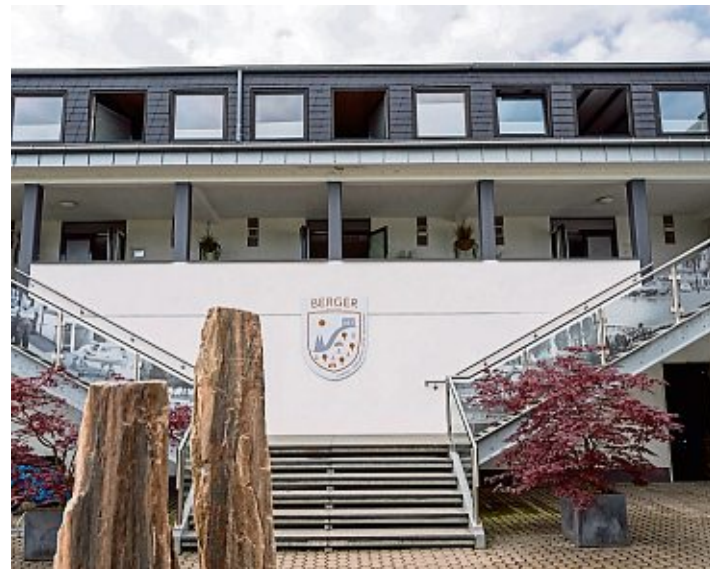
Die Treppen führen zu den Waschräumen. Die untere Ebene wird bei Hochwasser geflutet. Daher liegen die Wohnräume oben.
